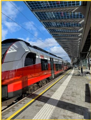
Abbildung 20: PV-Bahnsteigüberdachung ÖBB Matzleinsdorferplatz, Foto: Architekturbüro Reinberg ZT GmbH
