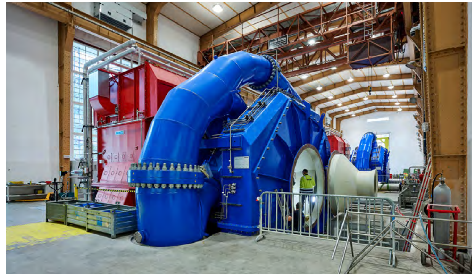
Technisch herausragend: Die im Vermuntwerk verbauten sechsdüsigen Peltonturbinen gehören zu den modernsten der Welt.
