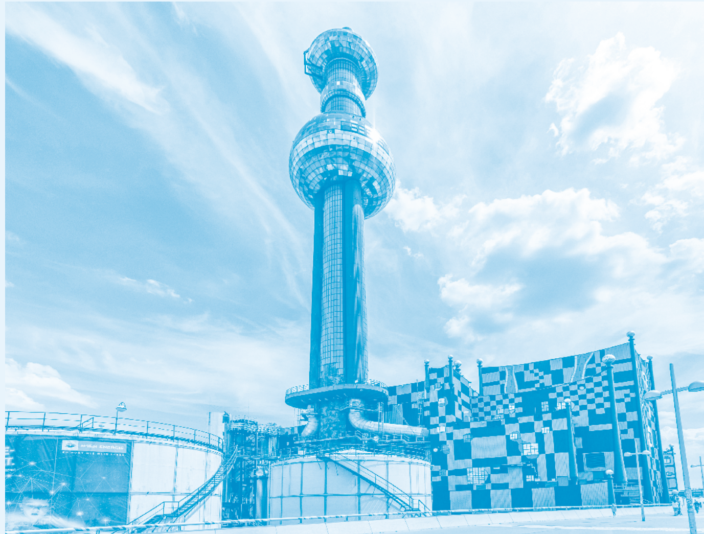
Die Müllverbrennungsanlage Spittelau versorgt Wien mit Fernwärme und Strom. Sie zeigt, welche Rolle zentrale Kraftwerksstandorte für die Energieversorgung einer Stadt spielen.
