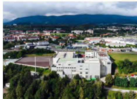
Kelag Energie & Wärme betreibt ab Mitte September das Biomasse-Heizkraftwerk Untere Fellach.
