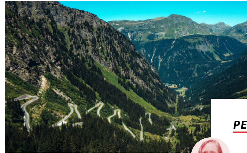
Silvretta-Hochalpenstraße als zentrale Zufahrtsachse für den Kraftwerksbetrieb in der Region derzeit gesperrt und künftig umfassend gesichert.
