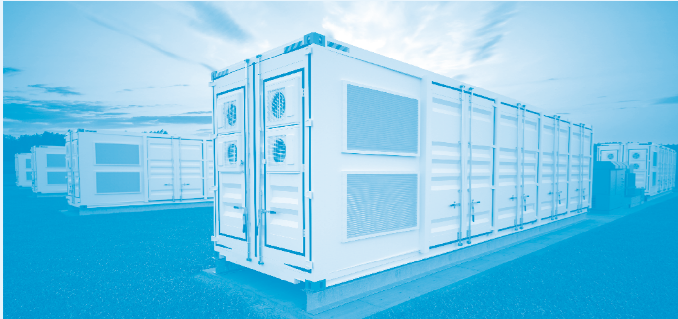
Kritische Rohstoffe: Zentrale Voraussetzung für die Transformation des Energiesystems
