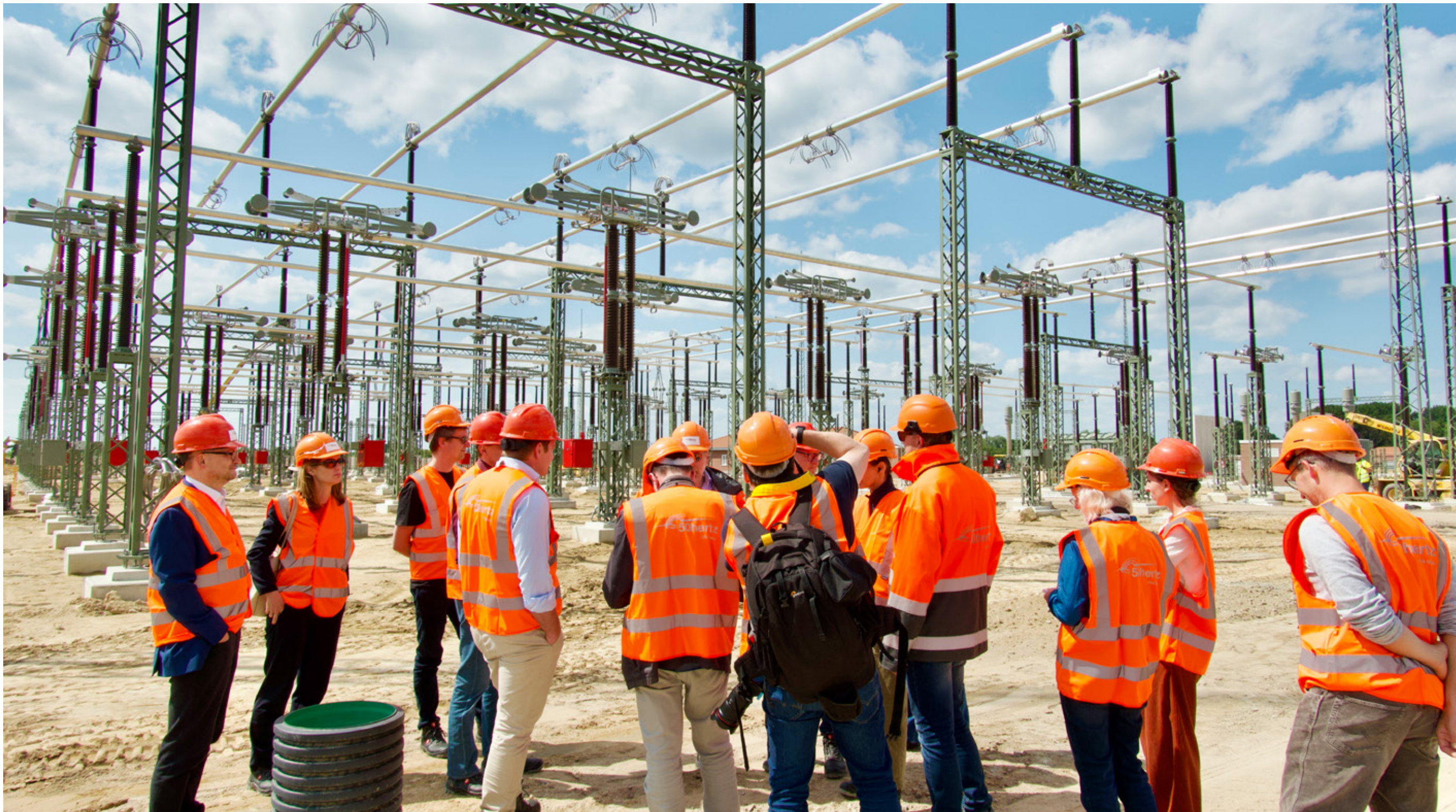
Baustelle des neuen Umspannwerks Stilow, das die 525-kV-Leitung „Ostwind 4“ und „Ostwind 3“ aufnimmt. Vertreterinnen und Vertreter ausgewählter Medien nutzten die Besichtigung, um sich aus erster Hand über die Herausforderungen des Netzausbaus zu informieren.
