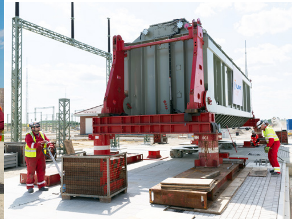
Ein 370 Tonnen schwerer Transformator, aus Sicherheitsgründen von einem zweiten Anbieter, wird in Millimeterarbeit in Position gebracht.
