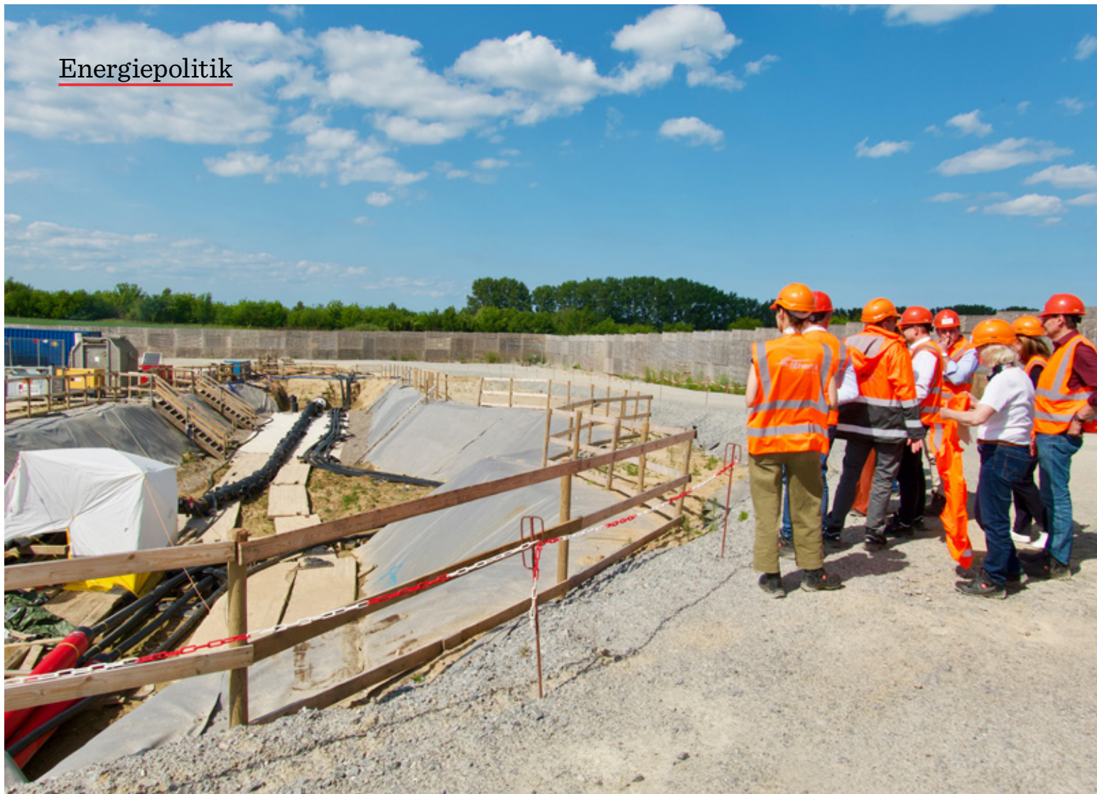
In ein paar Metern Tiefe liegt das Stromkabel, das Windstrom aus den 40 Kilometer entfernten Offshore-Parks zwischen Rügen und Bornholm an Land bringen soll.
