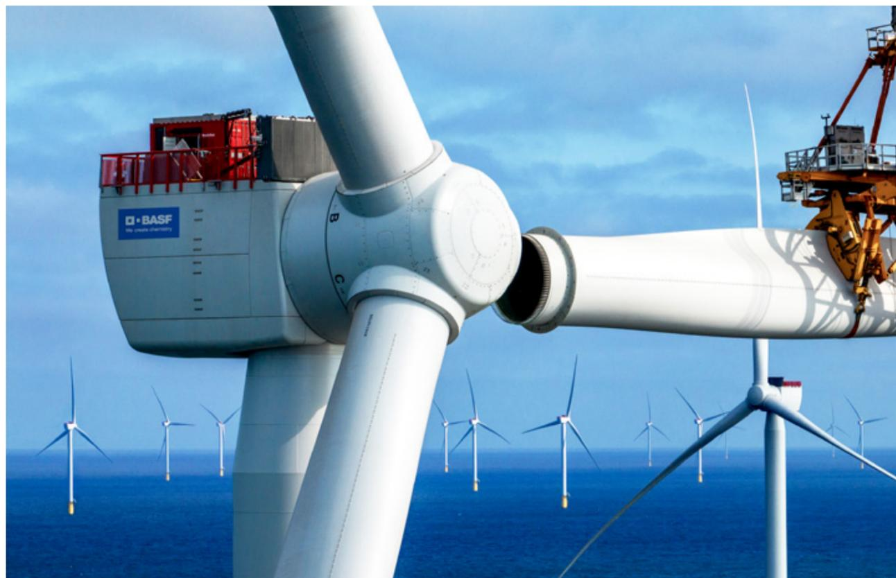
Montage des letzten Rotorblatts im Windpark Hollandse Kust Zuid.
