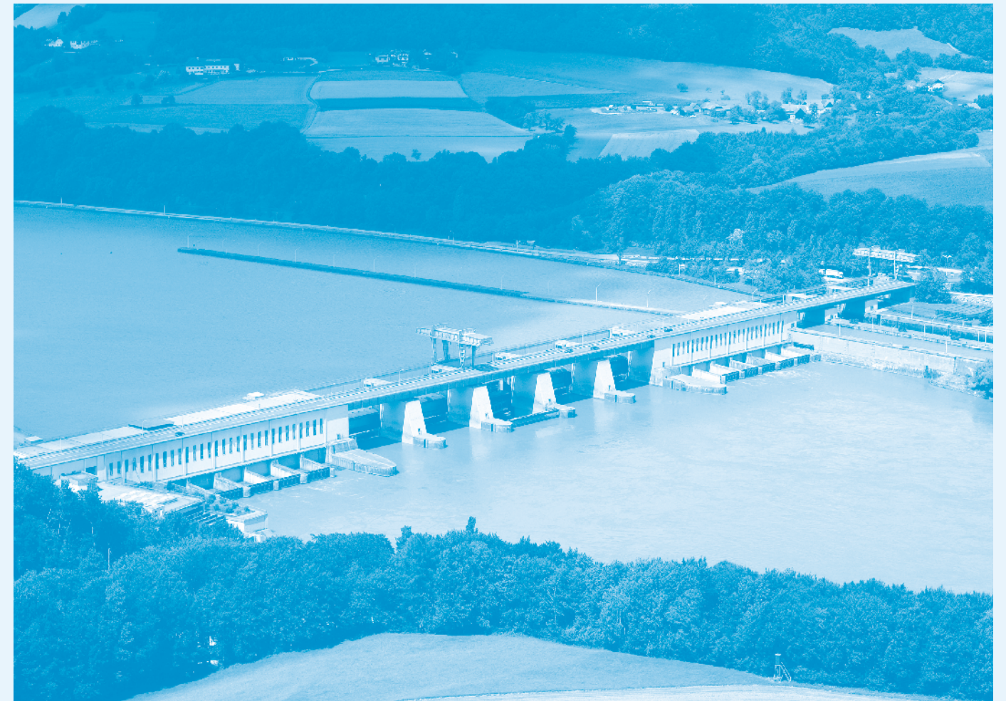
Wasserkraftwerk Ybbs-Persenbeug: Mehr als ein Drittel des Rohpotenzials ist entlang von Donau und Inn sowie ihrer seitlichen Zubringer verortet.
