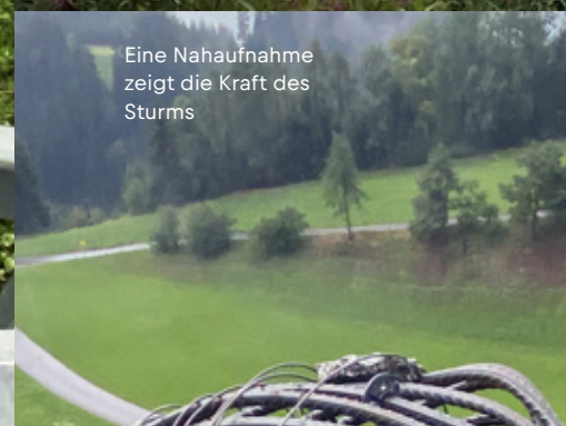
Schaden im Versorgungsgebiet der Energie Steiermark
