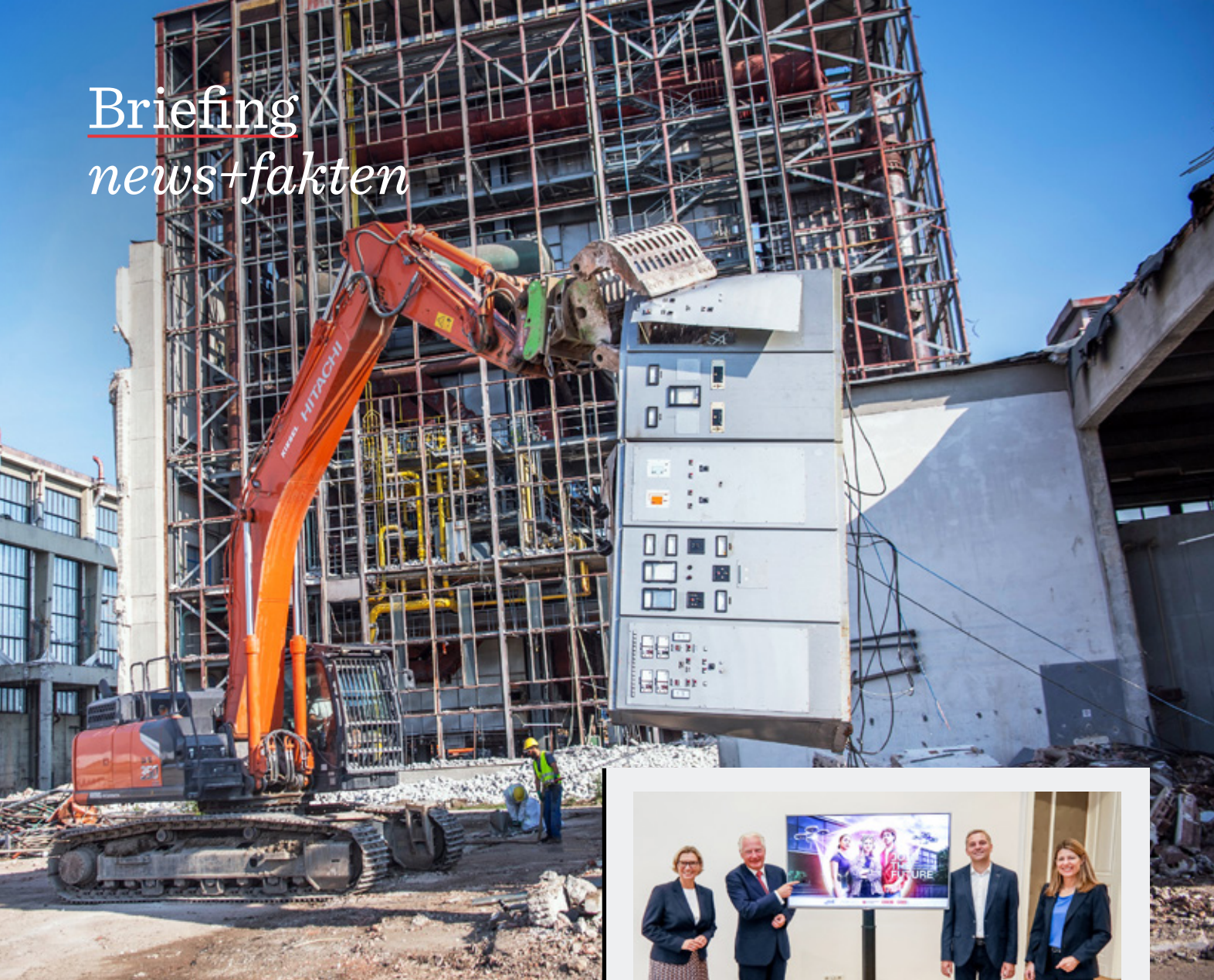
Verläuft weiterhin alles nach Plan, werden die Rückbauarbeiten im November 2023 abgeschlossen sein.
