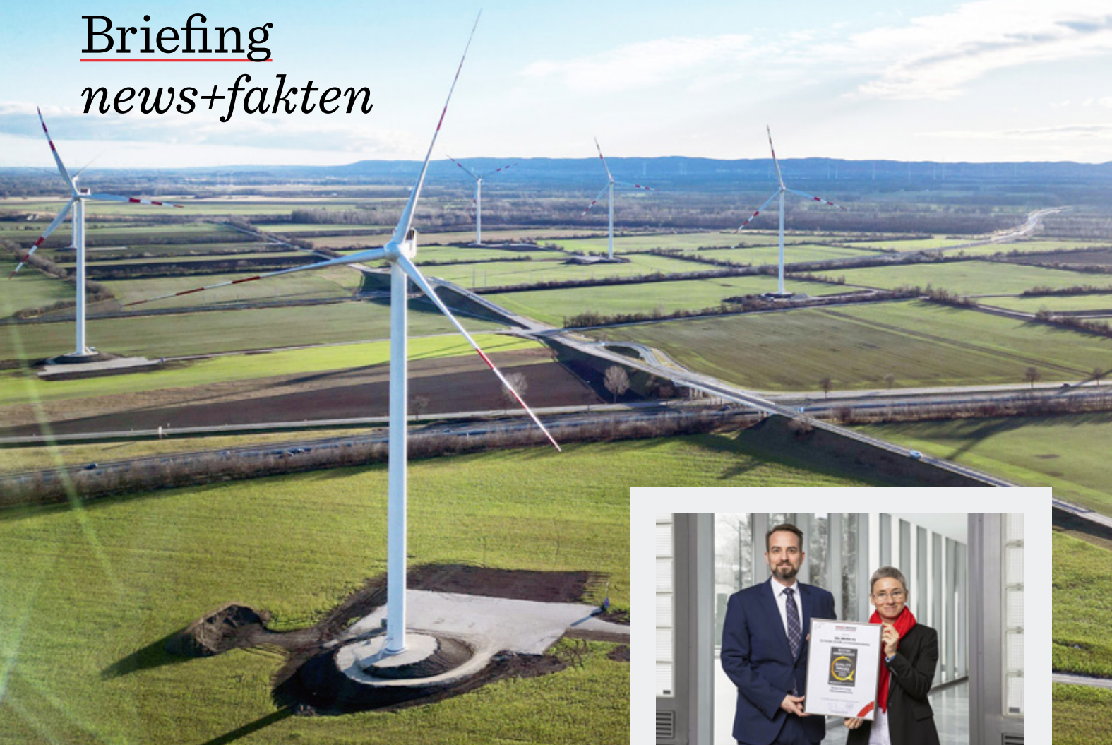
Windpark und Photovoltaikanlage erzeugen ab Jahresbeginn 2023 zusammen Ökostrom für 17.400 Haushalte.
