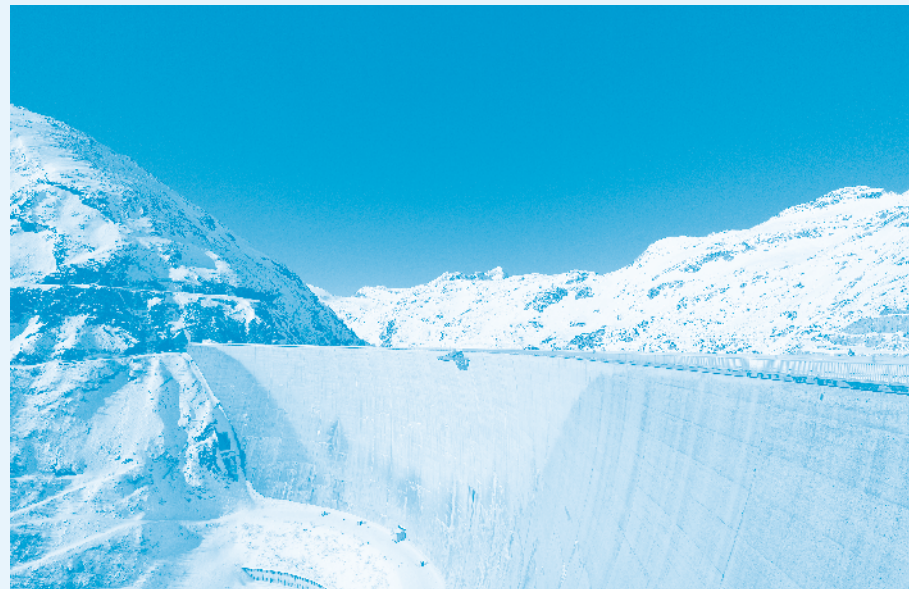
Das Pumpspeicherkraftwerk Malta-Hauptstufe in der Rottau
