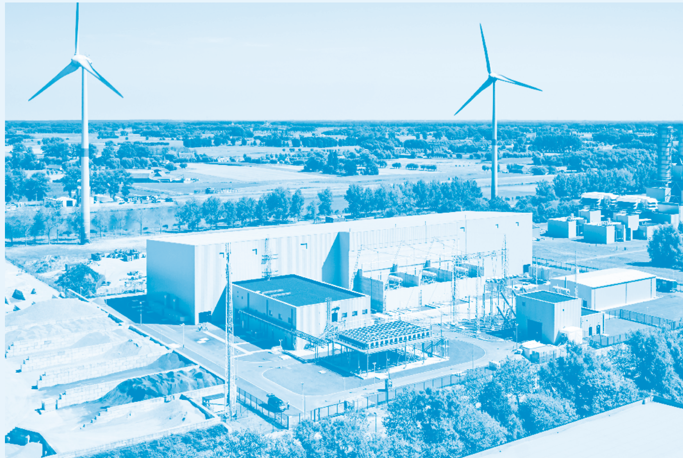
Spitzentechnologie: Gleichstrom-Transformatoren gelten als Meisterwerke des Trafo-Baus.
