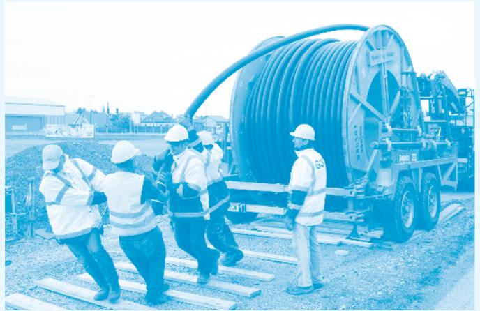
**Muffengrube, Erdkabel-Verlegearbeiten: Erdkabel können aus Transportgründen nur in Teilstücken von maximal 1000 Metern angeliefert werden. Daher müssen die Kabelstränge regelmäßig mit Kabelmuffen verbunden werden.**
