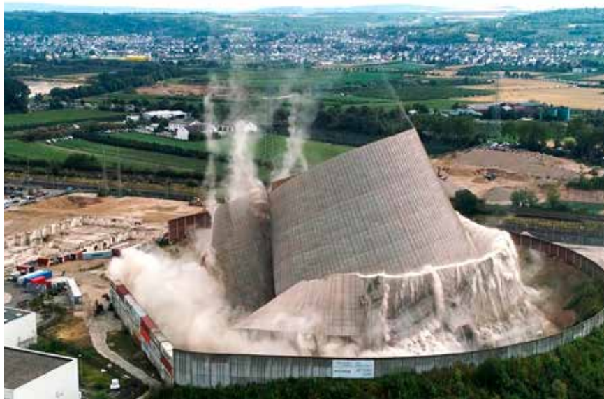
Abriss des Atomkraftwerks Muelheim-Kaerlich im Juli 2019: Nuklearenergie nur noch „Übergangstätigkeit“ auf dem Weg zur nachhaltigen Energieerzeugung in der EU
