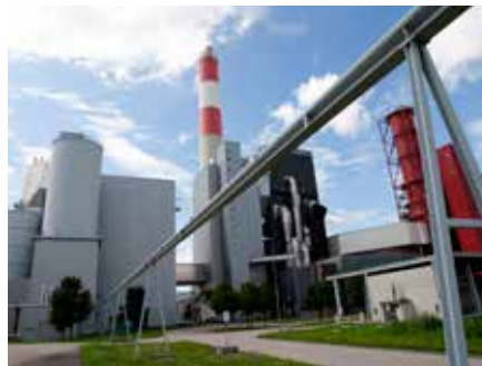
Alles vorbereitet: Die EVN hat alle Vorkehrungen getroffen, um den Betrieb des wichtigen thermischen Kraftwerks Theiß auch unter verschärften Bedingungen zu gewährleisten
