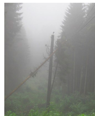
Bild: Baumfall in eine Leitung
