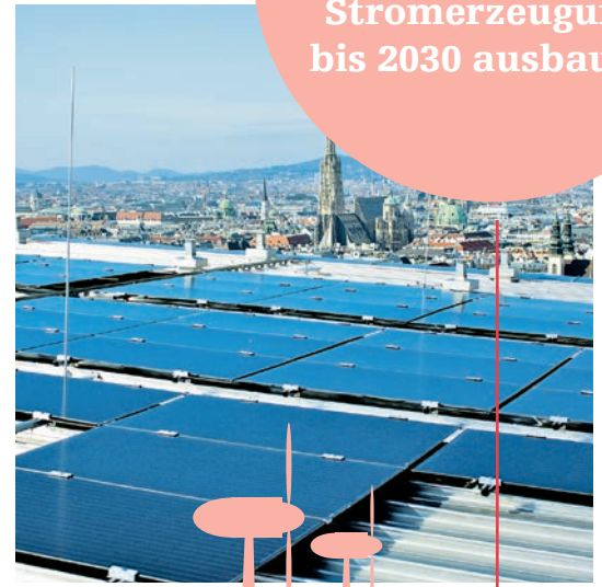
Foto: Wien Energie
