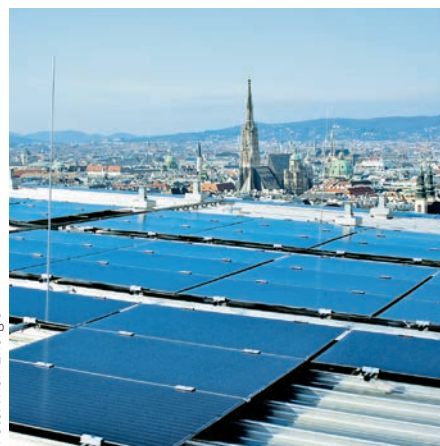
Foto: Wien Energie
